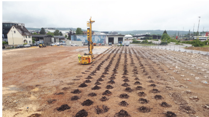
Bevor es an die Entsorgung von Altlasten geht, damit ein Areal neu bebaut werden kann, müssen zunächst Bodenproben analysiert werden
